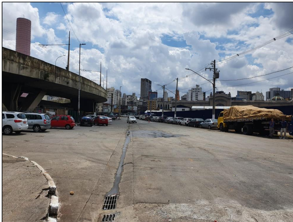
Figura 10 – Vista do armazém existente embaixo do Viaduto Diário Popular
