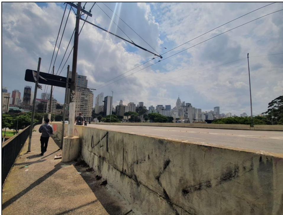
Figura 9 – Vista da travessia de pedestres no Viaduto 25 de Março
