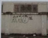
Galpão da CPTM - entrada e muro.
