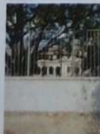
Muro e grades após as obras.
