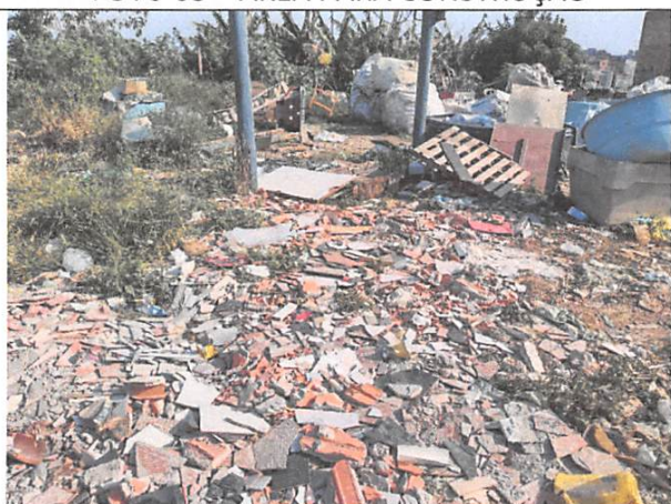
FOTO 05 – ÁREA PARA CONSTRUÇÃO
