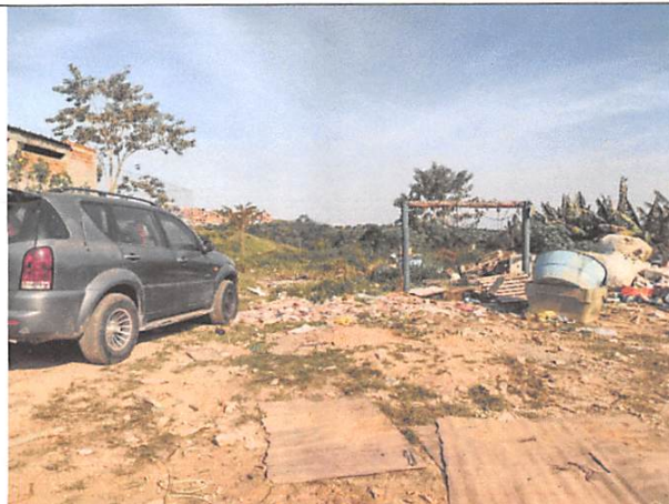
FOTO 02 – ÁREA PARA CONSTRUÇÃO
