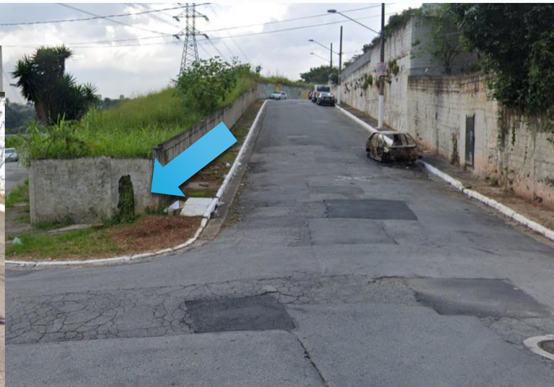
Muro quebrado para acesso
