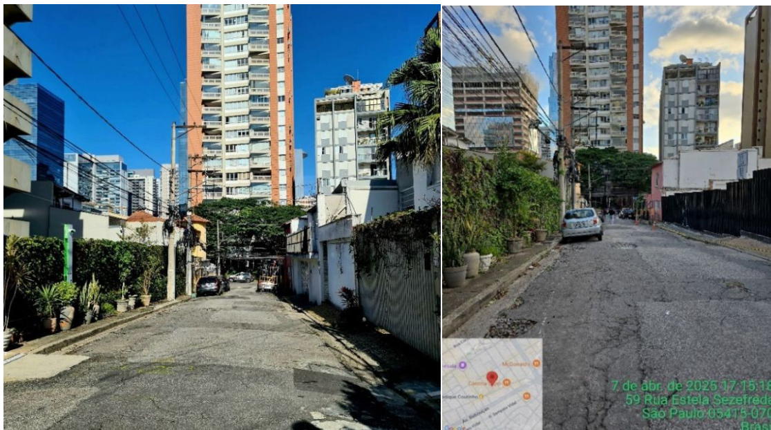
Rua Estela Sezefreda antes e depois da demolição.
