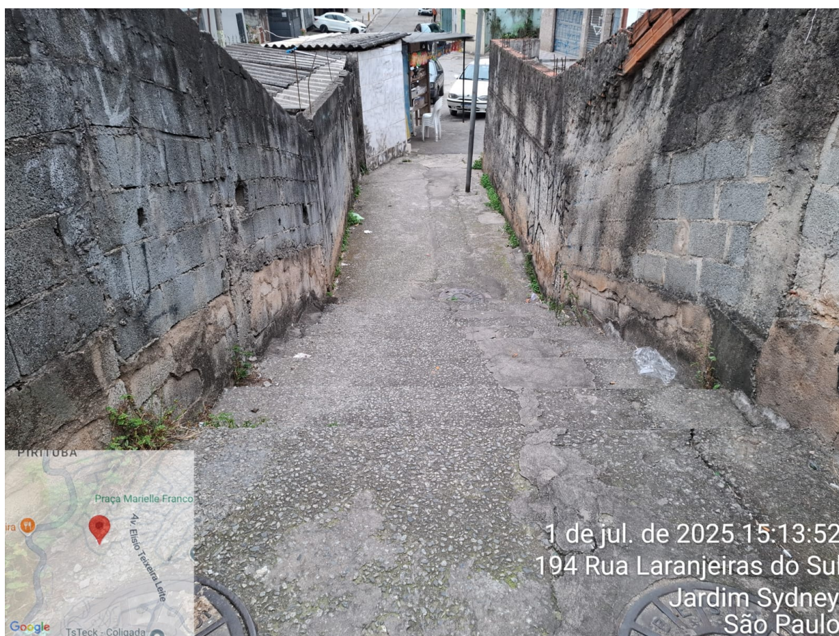
Rede de esgoto
