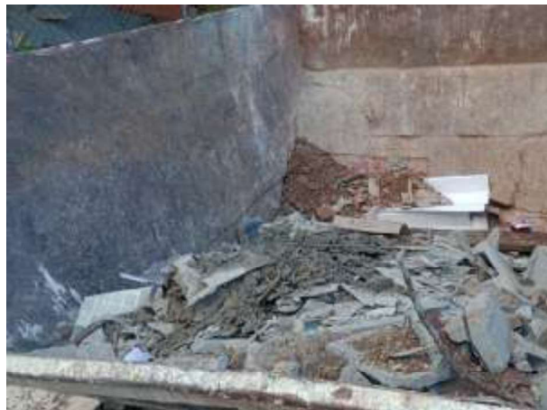
FOTO 02 – REMOÇÃO DE ENTULHO COM CAÇAMBA METÁLICA
