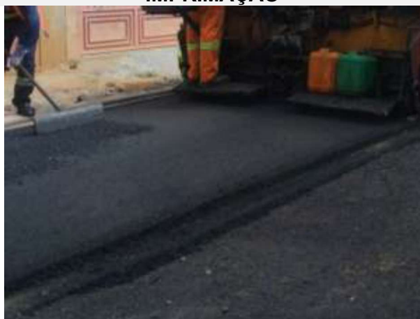
FOTO 16 – EXECUÇÃO DE CAMADA DE ASFALTO
