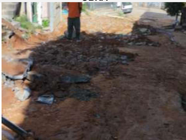
FOTO 03 – DEMOLIÇÃO DE PAVIMENTO EXISTENTE
