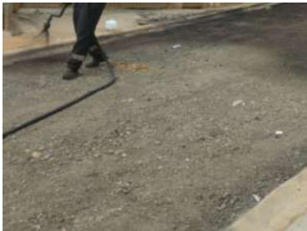
FOTO 13 – EXECUÇÃO DE CAMADA DE IMPRIMAÇÃO
