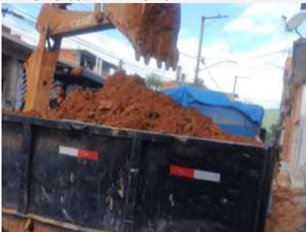
FOTO 11 – REMOÇÃO DE TERRA COM CAMINHÃO BASCULANTE
