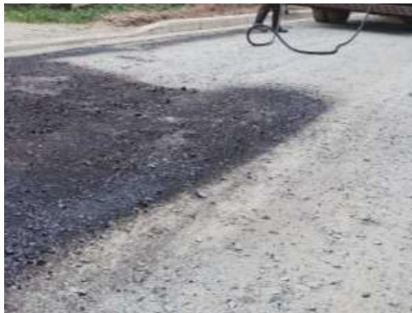
FOTO 14 – EXECUÇÃO DE CAMADA DE IMPRIMAÇÃO
