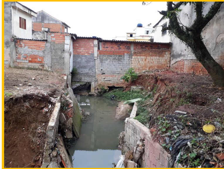
Meio córrego atrás Rua Céu
