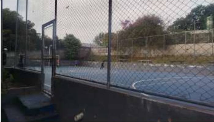
Imagem 1 – Estrutura atual da quadra esportiva.
