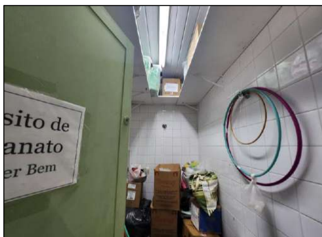
22 - BANHEIRO DESATIVADO – ALMOXARIFADO
