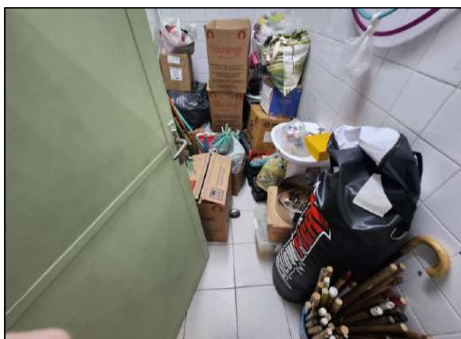
21 – BANHEIRO DESATIVADO – ALMOXARIFADO
