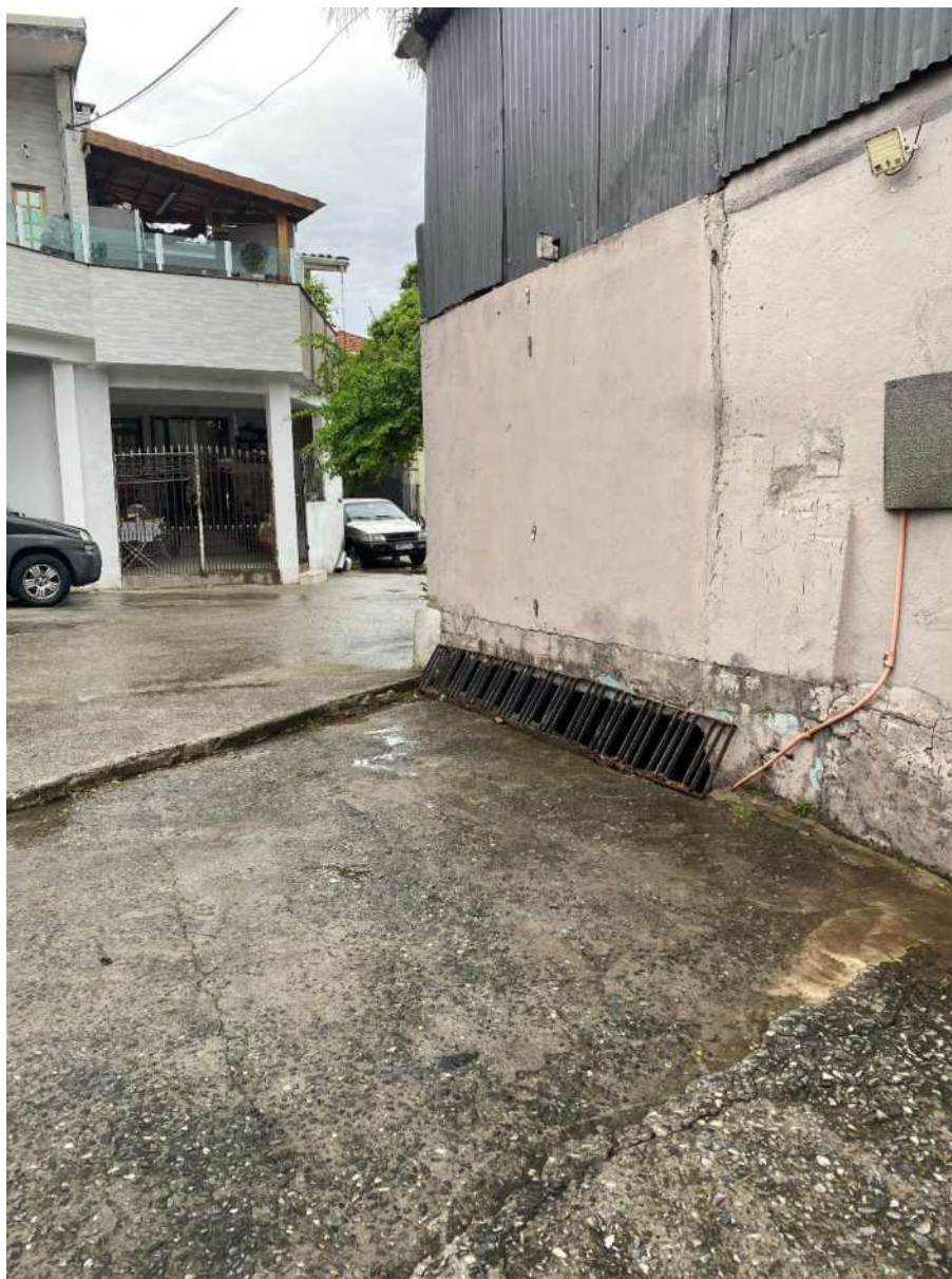
Figura 3 – Avenida Daniel Malettini, local de interesse, abertura para acesso a galeria do canal principal do córrego Vila Aurora
