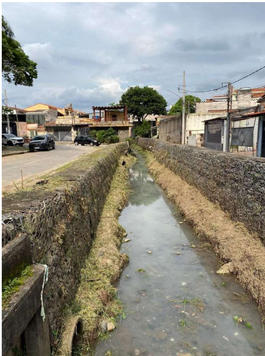
Figura 5 – Fotos da travessia do canal principal com a Travessa Pascoal Presto, visão a montante
