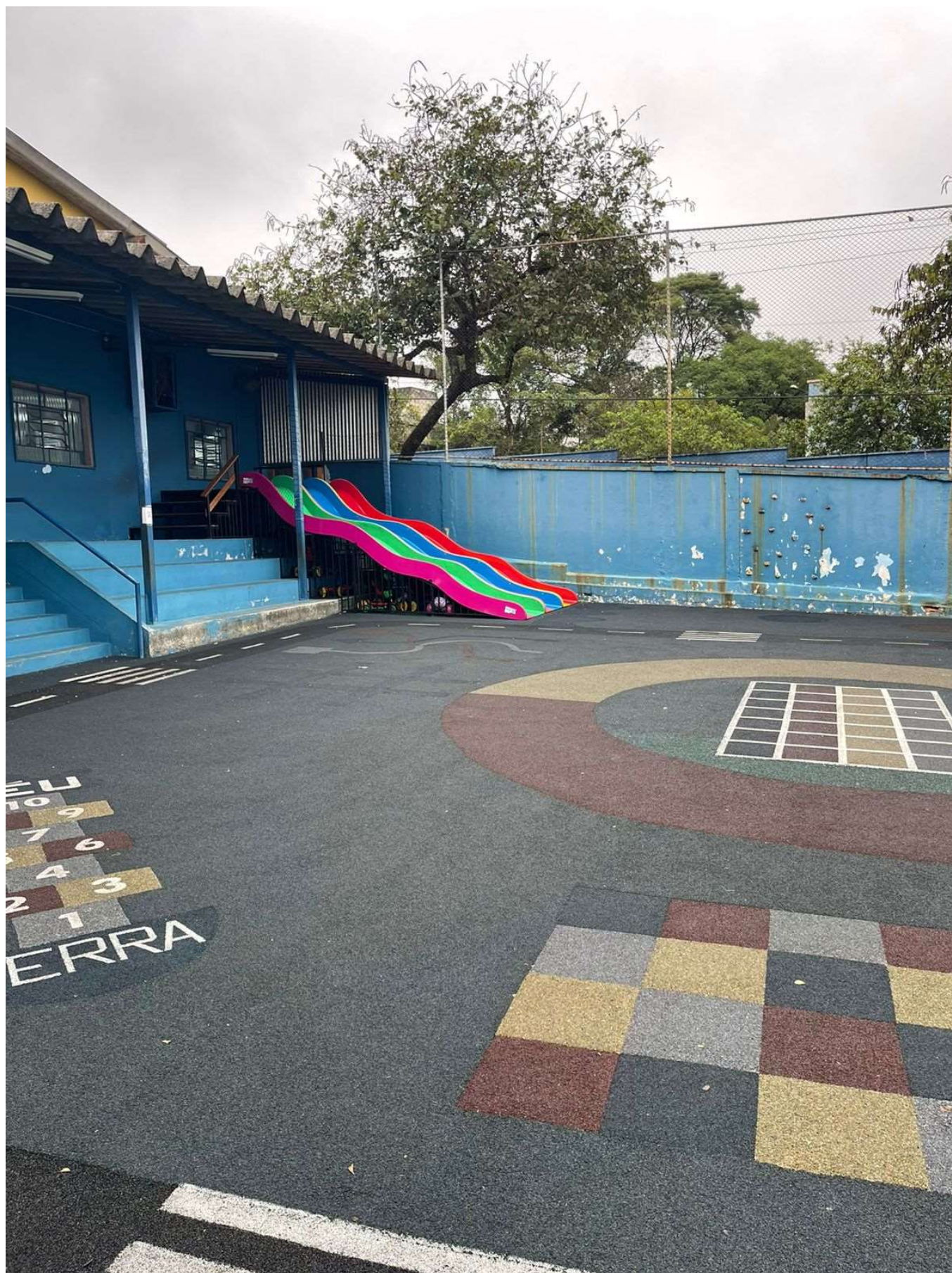
Figura 3- Local desejado para instalação da cobertura;
