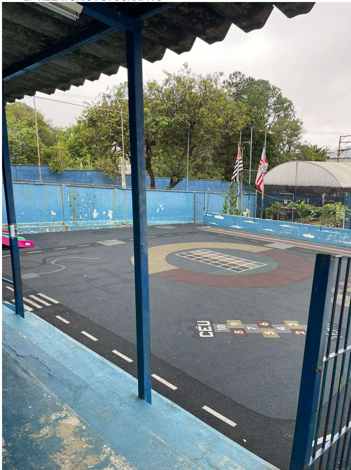
Figura 2- Local desejado para instalação da cobertura da quadra;
